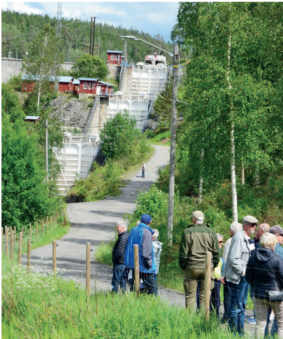
Brekke sluser i Haldenkanalen er Europas høyeste sluseanlegg med en løftehøyde på 26 meter.
