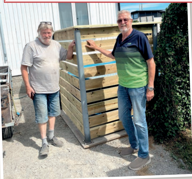
Dugand i juni. Stein og Leif Ingar har satt opp vegg ved bolighuset. I tillegg har det vært graving og grusing av plassen hvor hengeren står. Foto Jarle Rønjom.
